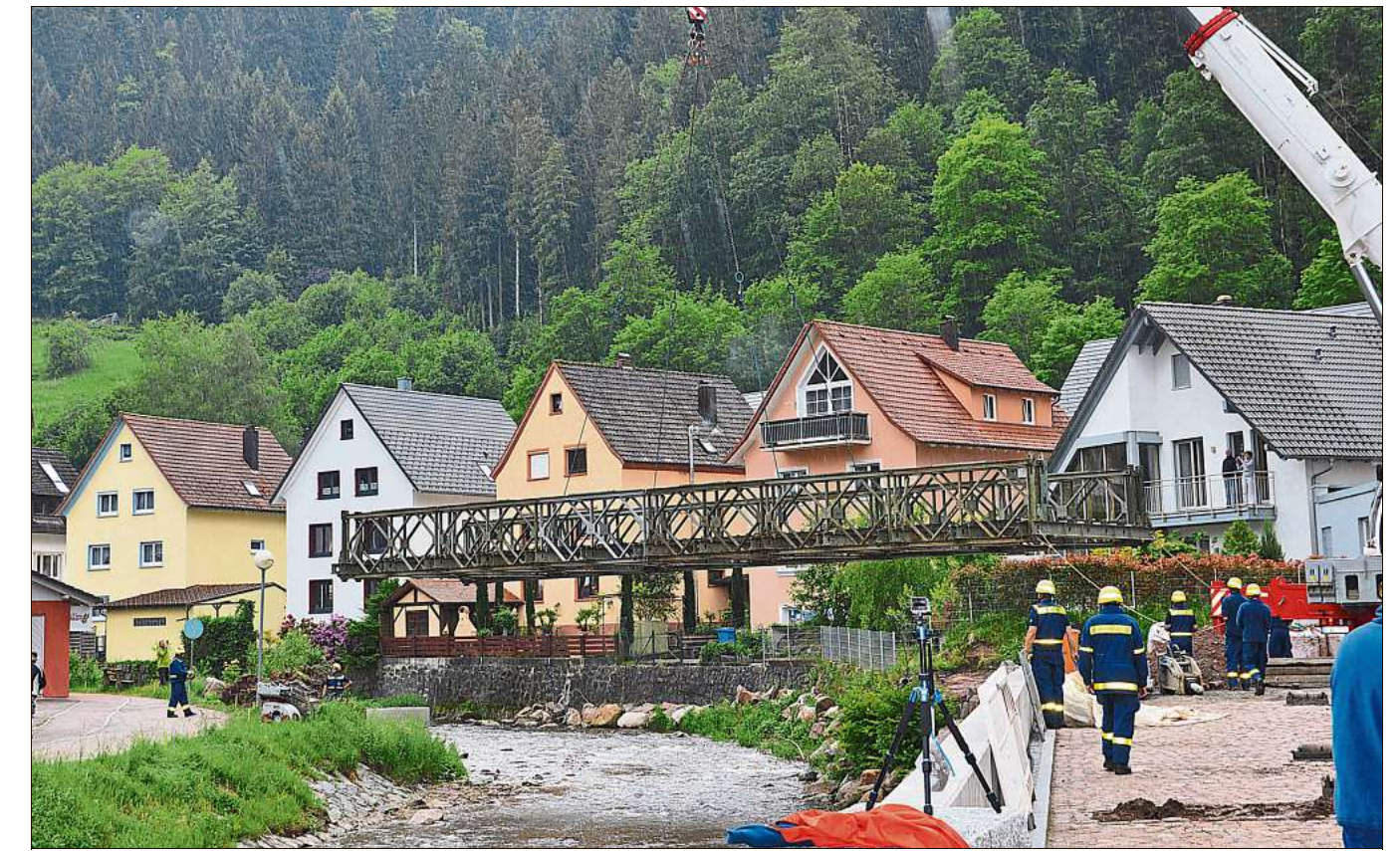
Der Autokran in der Bachstraße lässt die vom THW Schramberg zusammengebaute Brücke über den Fluss schweben. Fotos: Fritsche
