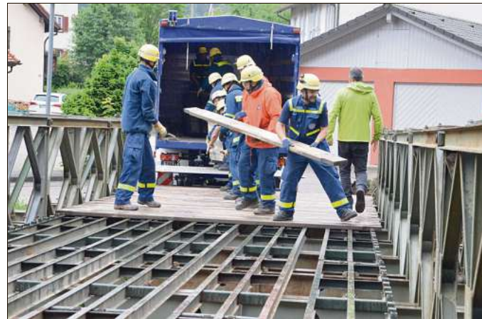
THW-Helfer decken die Stahlträger der Brücke mit stabilen Bretterbohlen ab und machen sie befahrbar.
