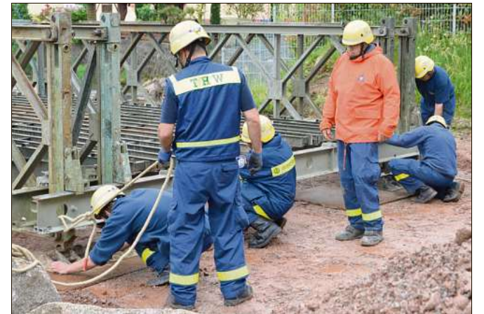
Zentimetergenau werden die Endpunkte der Brücke auf die Betonfundamente aufgesetzt.
